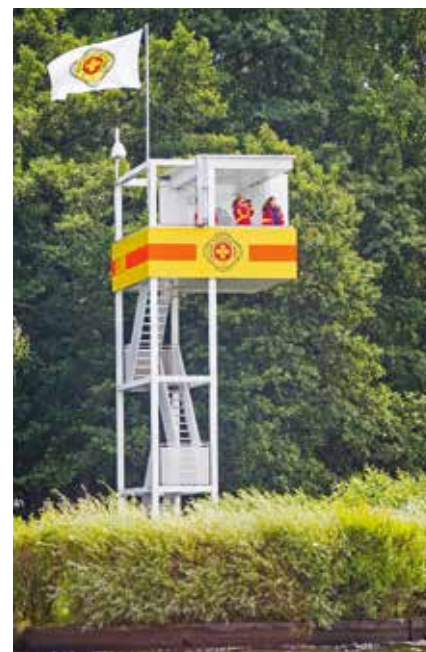
An jeder Wasserrettungsstation steht ein Wachturm. Von dort aus haben die Retter alles im Blick.
